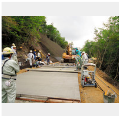
山口県宇部市で昨年6月にあった「1 DAY PAVE」を使った舗装工事=セメント協会提供
