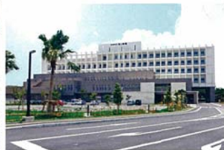
平成25年度に新宮古病院が完成
